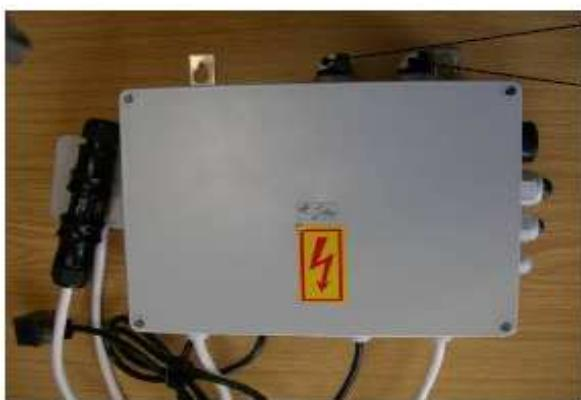
**Vypínač na rozvodnici v ČOV slúži len pre vypnutie a zapnutie dúchadla**
